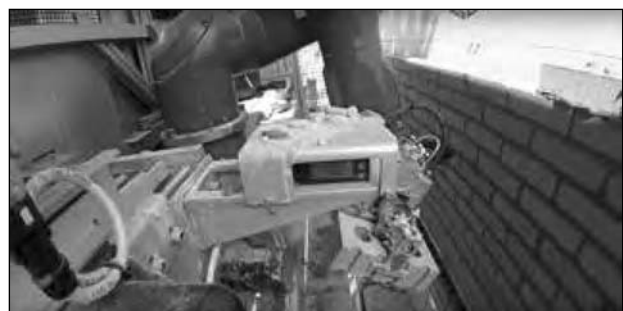
Рис. 2. Напівавтоматичний робот SAM компанії Construction Robotics [10]
